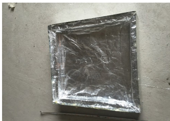
Рис. 5. Закрываем ее алюминиевой фольгой — это отражатель тепла
