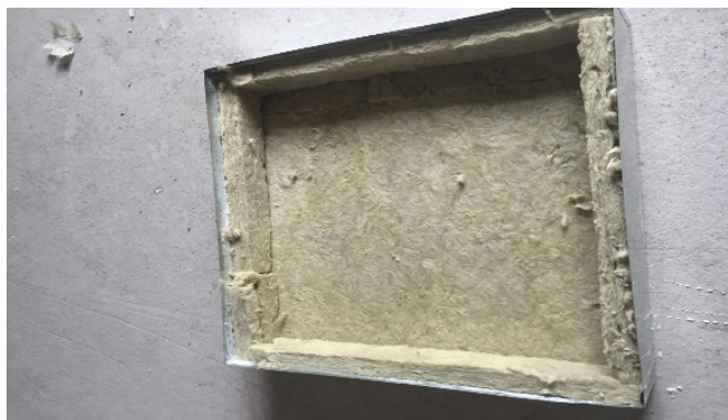
Рис. 4. На дно корпуса укладываем базальтовую теплоизоляцию 50 мм
